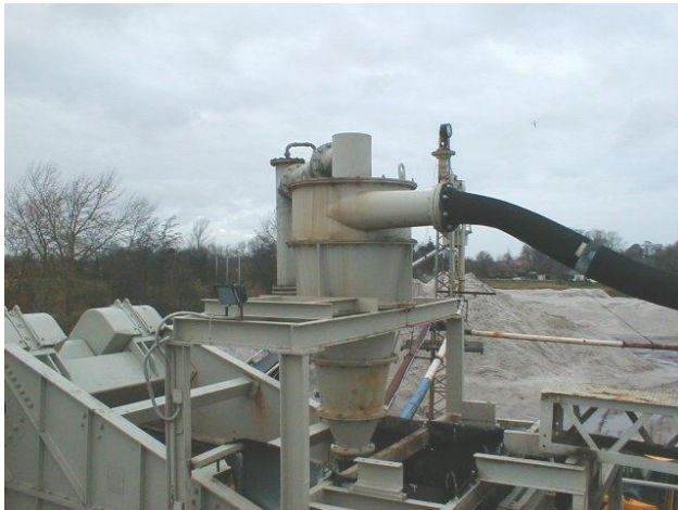
Z8 mit Austrag auf Entwässerungssieb
