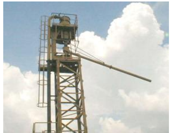
Z6 als Haldenzyklon mit Turm und Auslaufrohr
